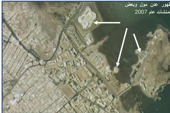
الشكل 4: صور جوية توضح المناطق التي رُدمت وحصل فيها تطور للمساحات والمنشآت والطرق.
