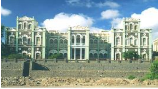
الشكل (19) يوضح منظرًا للواجهة الشمالية للقصر [10]
