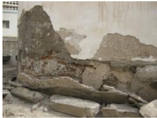
(شكل- 1) صور حديثة للباحث تبين أن الجدران الخارجية للمنارة مبنية من الأجر المحروق.
