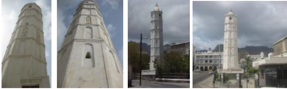
شكل 11- صور للمنارة توضح ميلان بعض البروزات ناتجة عن عيوب في الترميمات السابقة.
