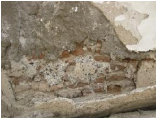
(شكل- 1) صور حديثة للباحث تبين أن الجدران الخارجية للمنارة مبنية من الأجر المحروق.
